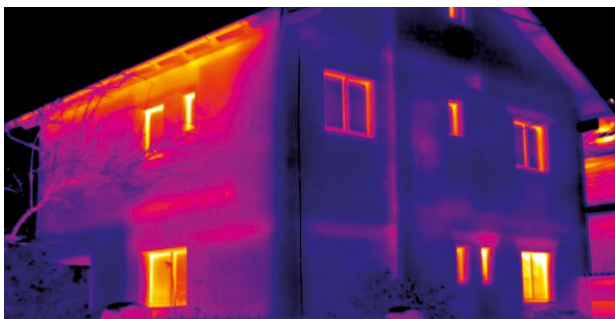
Gebäudeanalyse: Wärmeverluste, Baufeuchte und Schimmel aufspüren.
