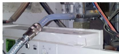
Gebrauchsfähigkeitsprüfung mit dem Adapter über die Gastherme
