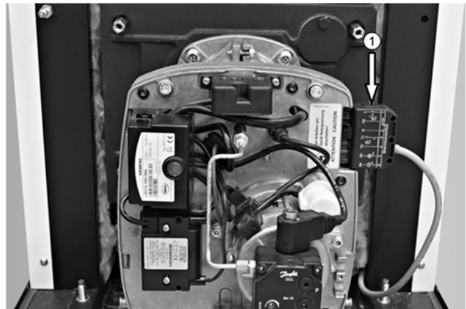
Abb. 12: Montage des Euro-Anschluss-Steckers ①
