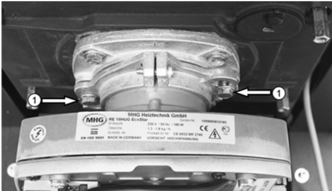
Abb. 34: Brennerbefestigungsschrauben
