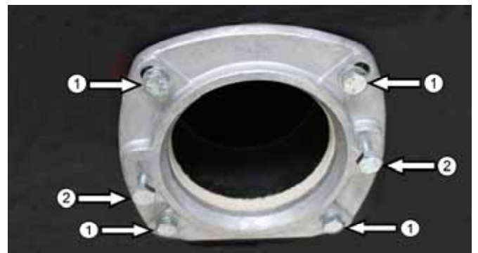
Abb. 6: Befestigung Kesselflansch
